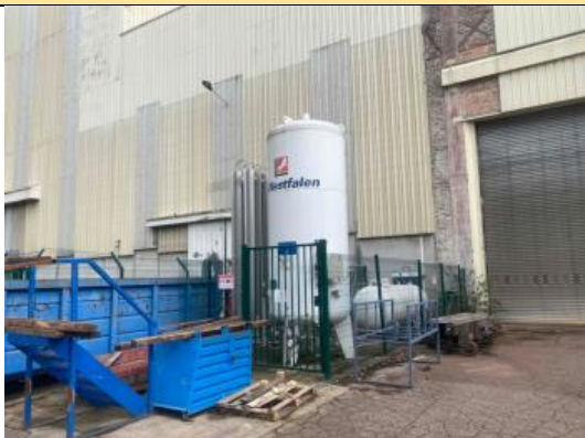
Photo de l'environnement de l'installation :
