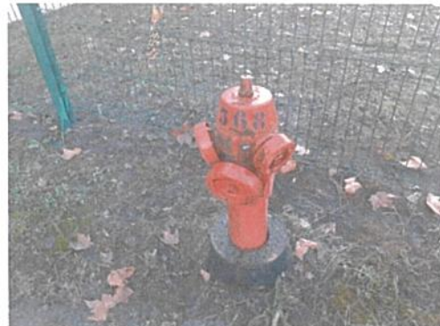
Photographie du point d'eau
